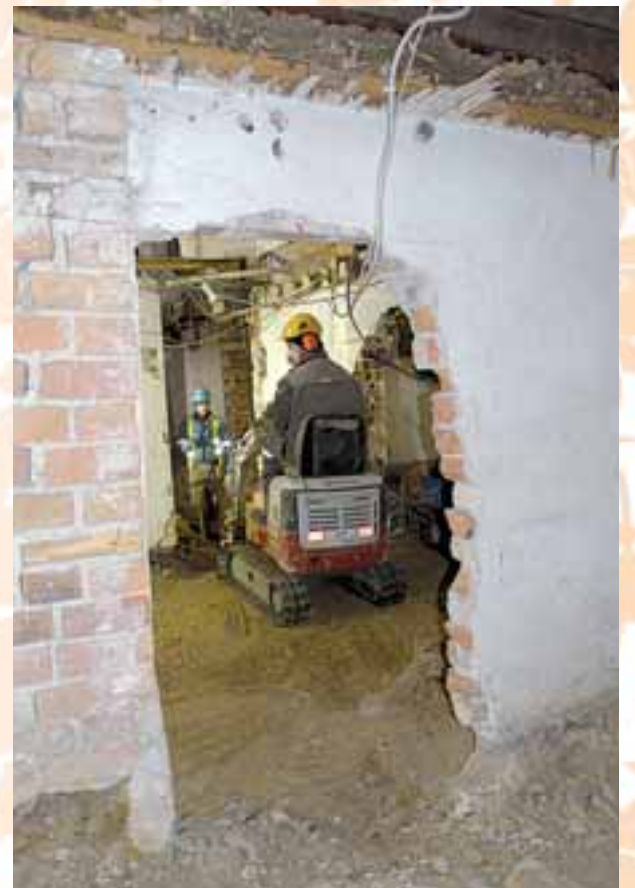
Bäckmanin talossa ovat vielä meneillään purku- ja louhintatyöt. Tässä louhintatöissä ollaan kellarikerroksen uumenissa.
