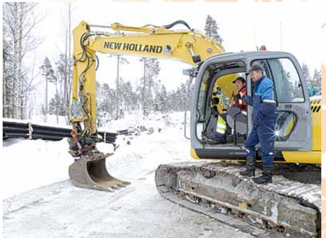
Urakoitsija Isto Sepän kaivinkonemiehet Hannu Pentti ja Pasi Koironen rakentavat Pikku-Kukkurin alueen kunnallistekniikkaa.
