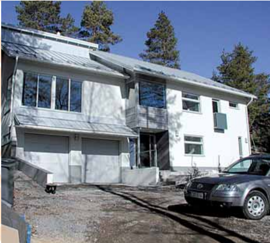
EPS-rakennusharkkoilla toteutettu kivitalo rappauspinnotteella.
