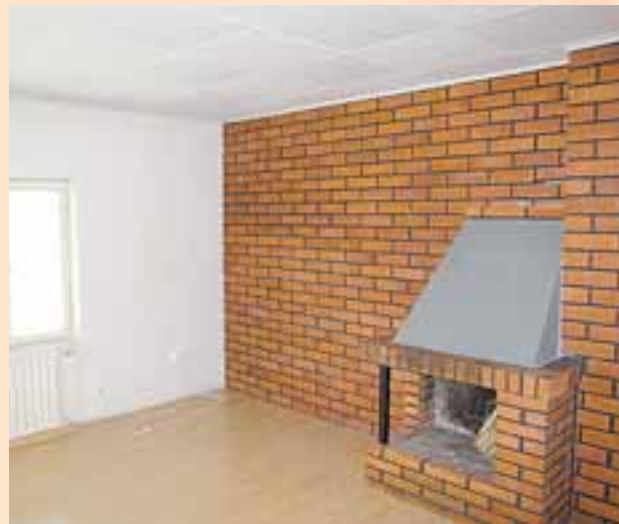
Olohuoneen kaikki pinnat olivat kuluneita ja takkakin haluttiin uusia.
