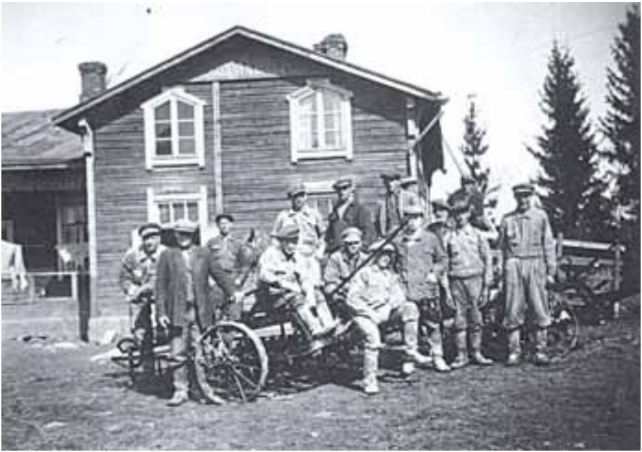
Pakkasen työväkeä sodan jälkeen, oikealla Alfred Viidanoja, takana Väinö Lehtinen, koneen päällä istumassa Antti Heikkinen. Kuvan omistaa Pasi Peltomäki.
