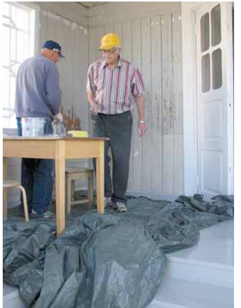
Miehet työssään. Viime viikolla vielä maalailtiin seinä ja kattoa. Lattia ja ikkunat olivat jo uusittu ja portaisiin saatu kaide. Kuvassa rakennusalan ammattilaiset Pentti ja Pekka Mäkinen.
