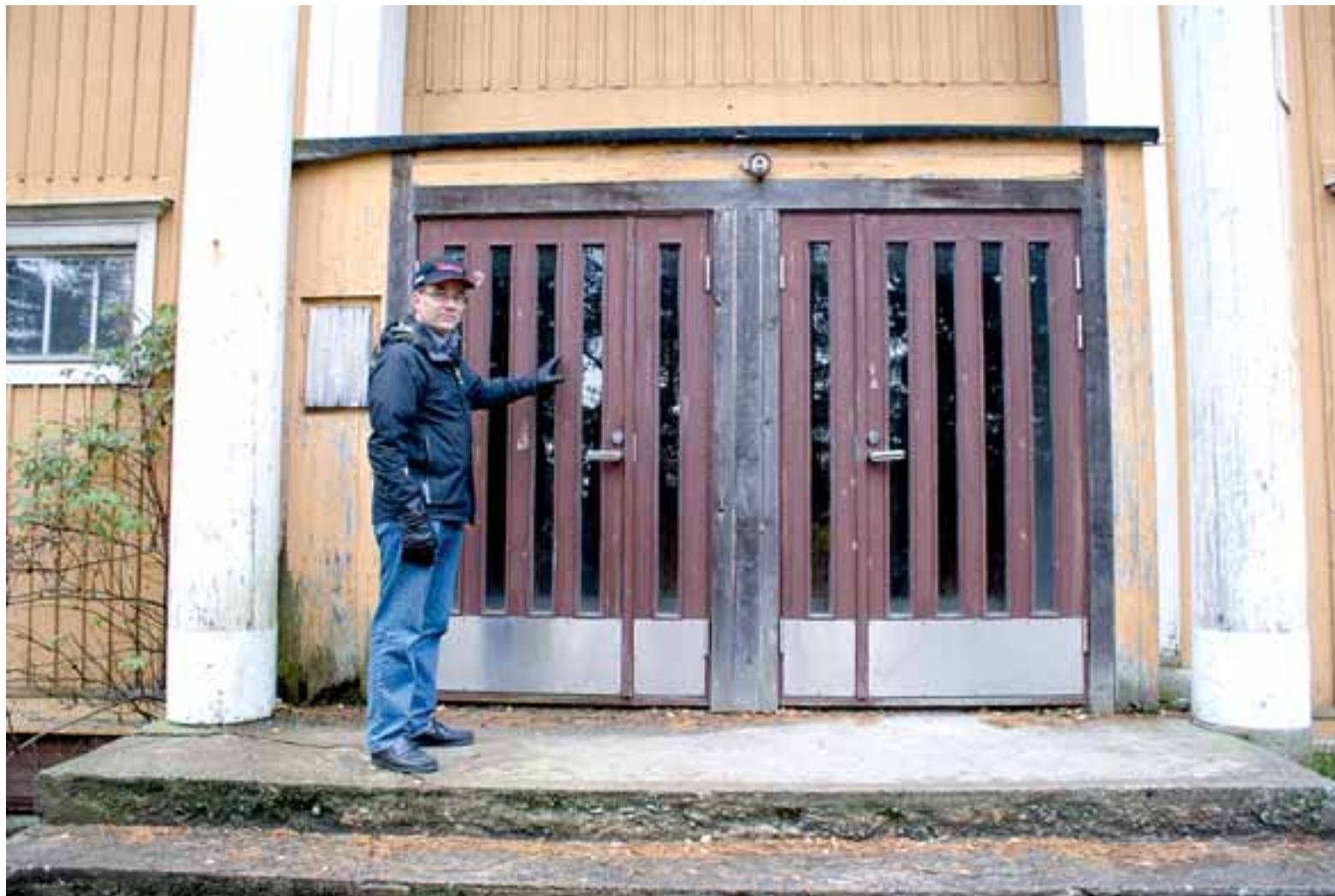
Remontoinnin lisäksi rakennusta myös entisöidään. Eteisaulaan palautetaan alkuperäiset yhdeksänruutuiset ikkunat ja ylimääräinen tuulikaappi poistetaan rakennuksesta kokonaan. Hanketta vetää Jukka Uusi-Kouvo.
