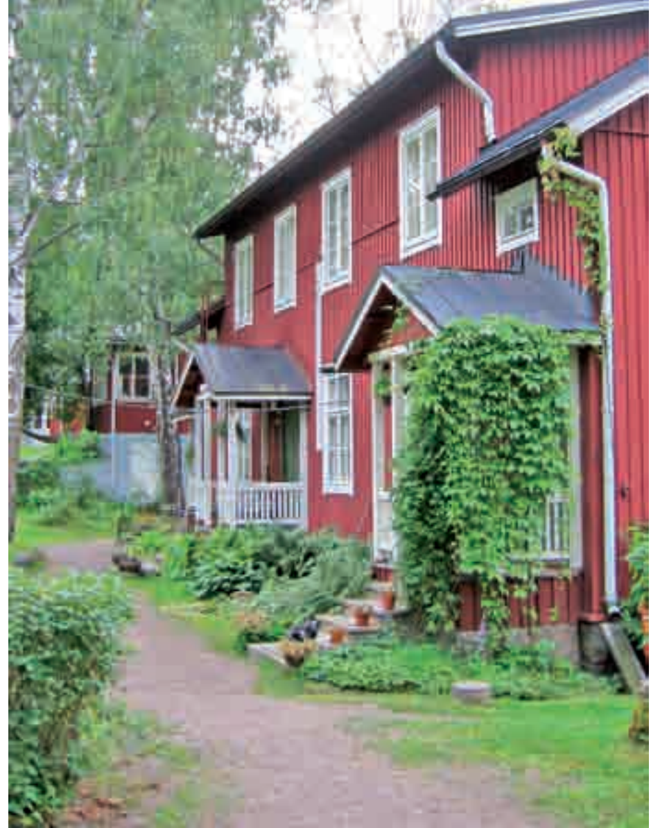
Pihapuutarhuri voi monin keinoin hoitaa talonsa terveyttä. Kannattaa muistaa, että esimerkiksi villiviinin voimakkaat ilmajuuret voivat pureutua seinärakenteen sisään ja kulkea katolla rännissä sekä vesikaton rakenteissa vaurioittaen niitä. Kuva: Ympäristöministeriön kuvapankki/Pirjo Ferin.
