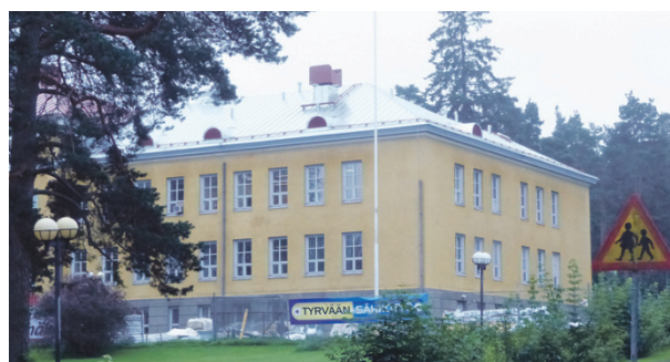
Sastamalan kaupungintalon kattoremontti edistyy aikataulussa.
